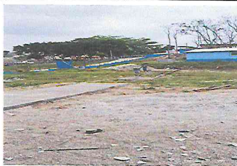
LOSA DE PATIO: seguimos trabajando en la fundición de losa de patio.
