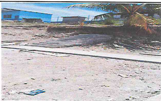
GRADAS el trabajo se estaba realizando en colocar las grada.
