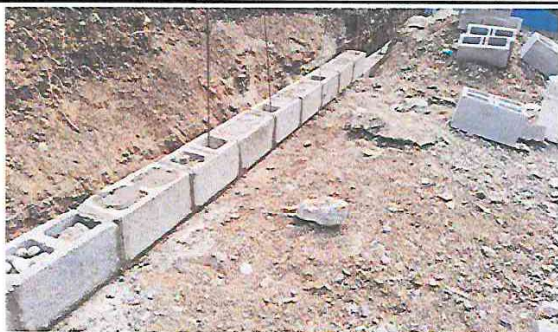
MURO DE CONTENCIÓN el trabajo estaba a media para la construcción de muro.
