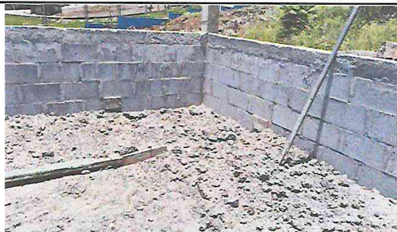
COCINA: se está construyendo la cocina del establecimiento
